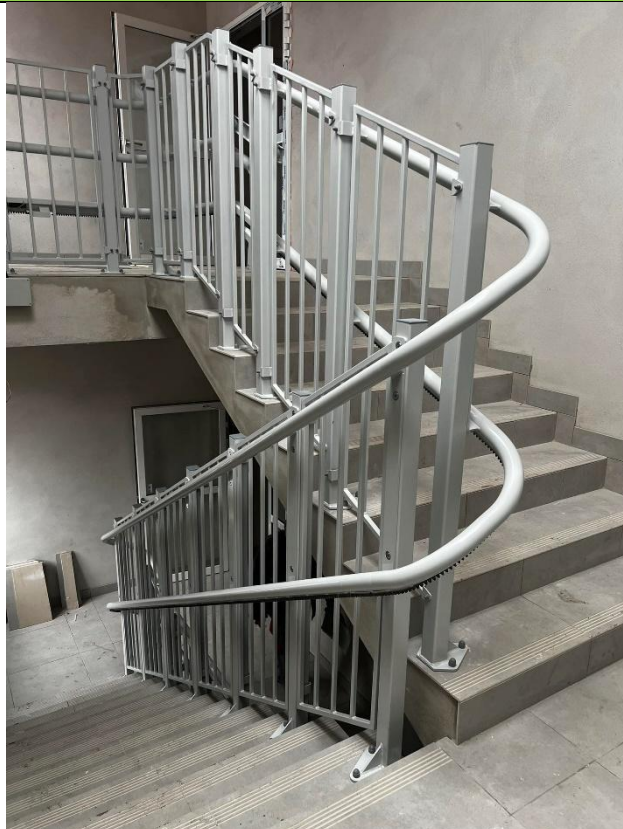
Przykład torowiska z zastosowanymi wypełnieniami przestrzeni pomiędzy słupkami z profili stalowych
